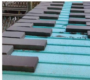
6. APLICAR AS PLAQUETAS KLINKER FACE A VISTA, COMEÇANDO PELAS PEÇAS DE CANTO E VERIFICANDO O ALINHAMENTO DA JUNTA VERTICAL- FREQUENTEMENTE.
