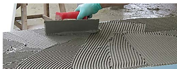
2. APLIQUE O ADESIVO NA PARTE POSTERIOR DAS PLACAS XPS (Colagem por pontos ou colagem total)
