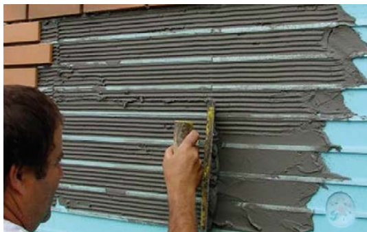
5. PREPARAR E APLICAR O ADESIVO CANDIWALL® SOBRE O XPS.
