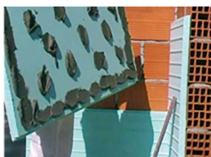
3. Aplicar correctamente as placas de XPS RESPEITANDO OS ENCAIXES MEIA MADEIRA.
