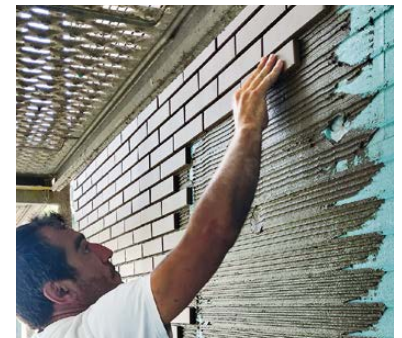
6. APLICAR AS PLAQUETAS KLINKER FACE A VISTA, COMEÇANDO PELAS PEÇAS DE CANTO E VERIFICANDO O ALINHAMENTO DA JUNTA VERTICAL- FREQUENTEMENTE.
