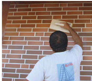
8. LIMPAR O EXCESSO DA ARGAMASSA DE REJUNTAMENTO COM ÁGUA LIMPA E UMA TALOCHA ESPONJA BEM ESPREMIDA UTILIZANDO UM BALDE COM ROLOS E LIMPANDO SEMPRE NA HORIZONTAL NO MESMO SENTIDO E MUDANDO DE ÁGUA COM FREQUÊNCIA ATÉ DEIXAR A SUPERFÍCIE COMPLETAMENTE LIMPA.
